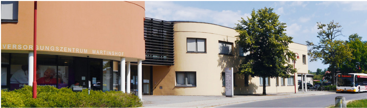
Medizinisches Versorgungszentrum Martinshof gGmbH in Rothenburg/Oberlausitz
